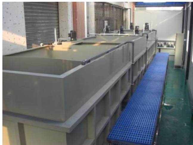
镍废水单独处理装置照片
